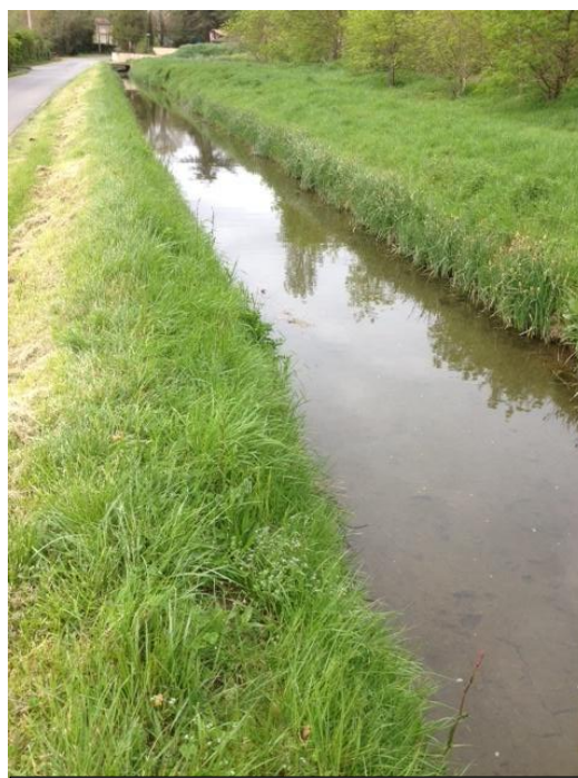
Canalet Chemin de la Cressonnière
